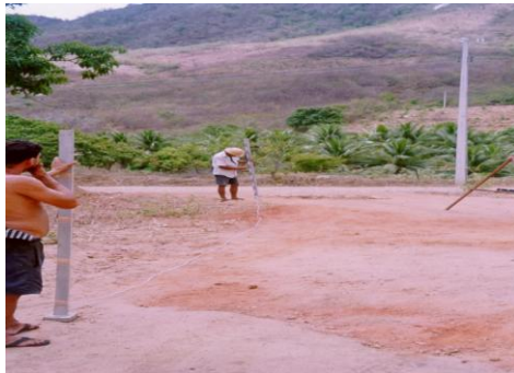
Foto 2: Marcação de curva de nível com nível de borracha – Valdir Silva
